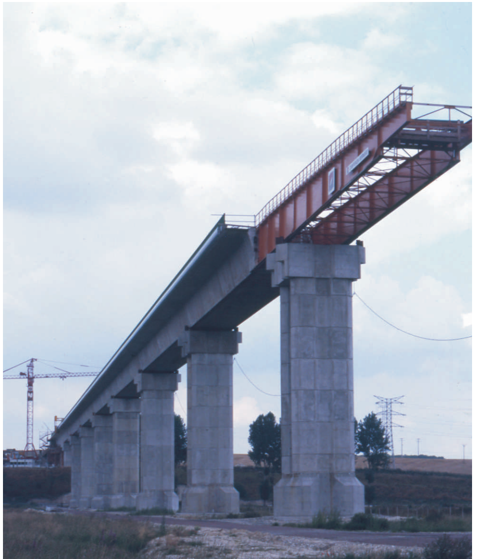
Jules Verne Viaduct
