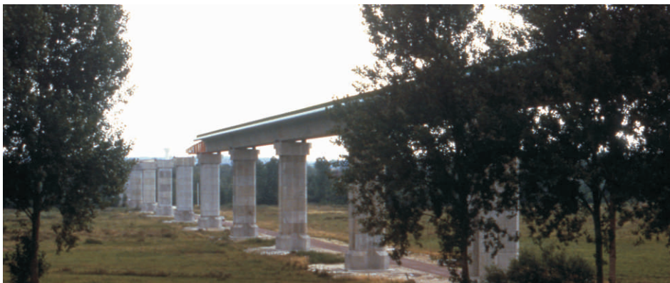
Jules Verne Viaduct
